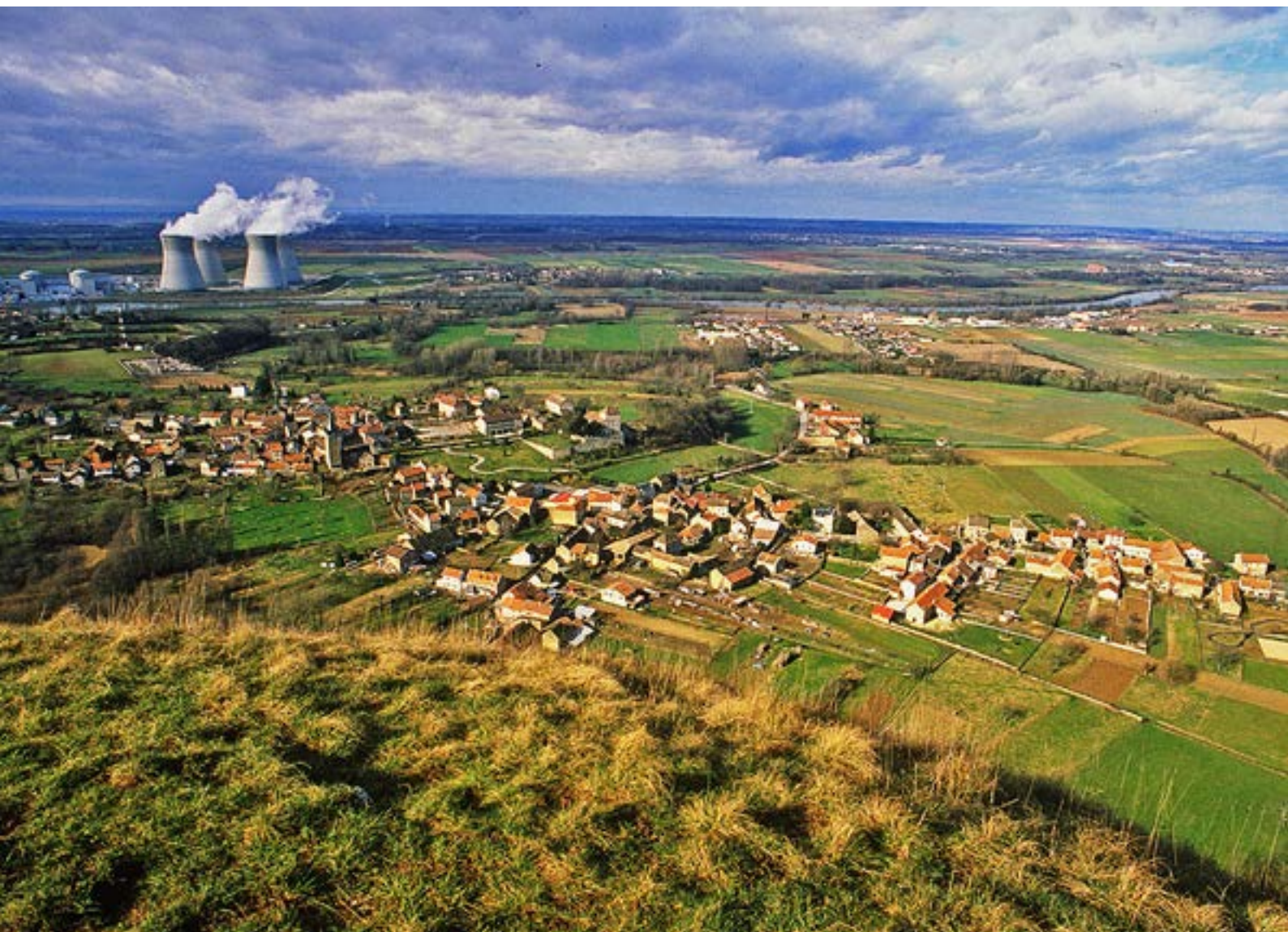
Centrale du Bugey
